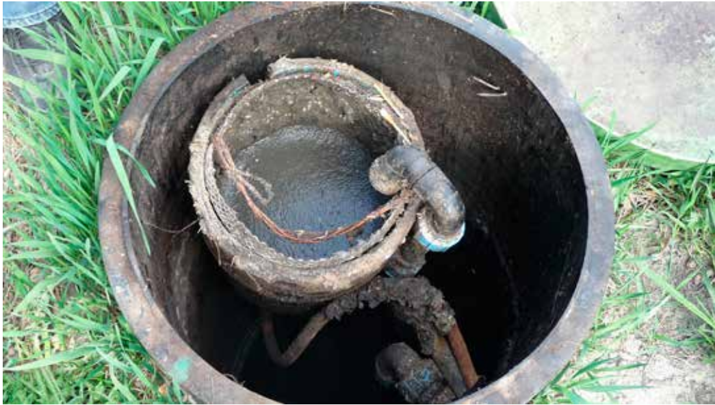
Kuva 10. Pienpuhdistamon ylijäämälietteen säiliö, joka on tyhjennettävä vähintään kerran vuodessa. (Kuva: Tuulia Innala)
